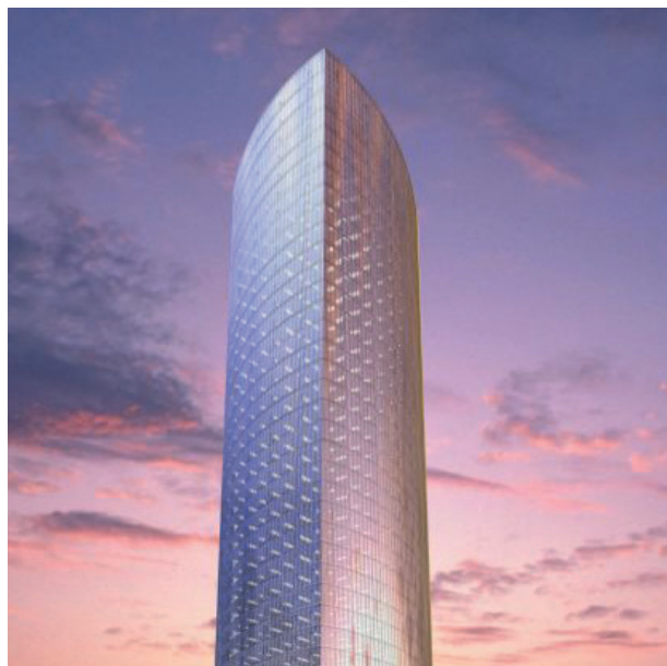
Instalación compensada por CYDESA. Torre Iberdrola (Bilbao)
